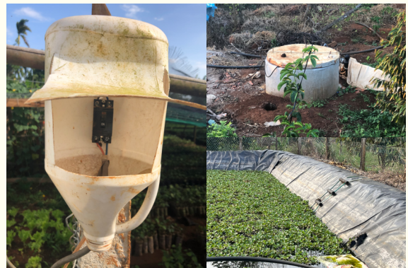
Bảo vệ thiết bị điện, đặt nắp giếng và thang lên xuống cho hồ nước
